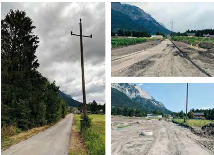
Neuerrichtung des Straßenkörpers von B111 in Richtung Nötsch
