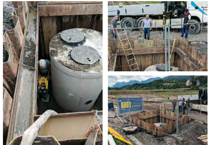
Errichtung einer Pumpstation für die Abwasserverbringung.
