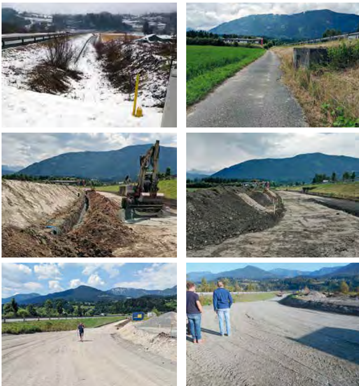
Baufortschrittentwicklung des Straßenkörpers parallel zur B111
