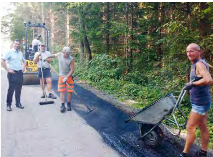
Bürgermeister Alfred Altersberger macht sich persönlich ein Bild der Sanierungsarbeiten.
